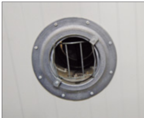
Figure 13. Soupape d'équilibrage.
