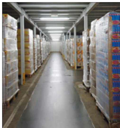
Figure 18. Dispositif d'éclairage par tubes fluorescents.
