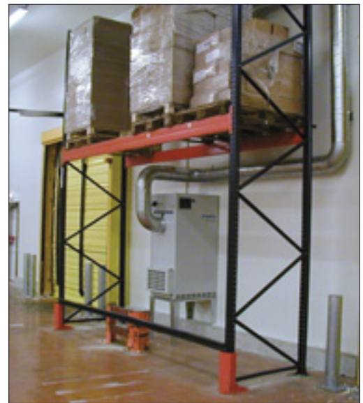
Figure 14. Assécheur d'air sur quai.
