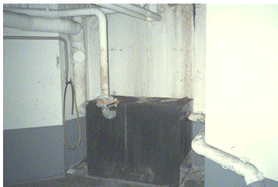
Bac à graisses de petite taille enterré [doc. COSTIC] Bac à graisses dans un local en sous-sol [doc. COSTIC]
