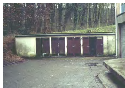
Le local peut éventuellement être séparé du bâtiment (ci-dessus un local déchets d'un restaurant collectif) [doc. COSTIC]
