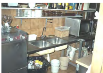
L'espace très limité dans les petits établissements [doc. COSTIC]
