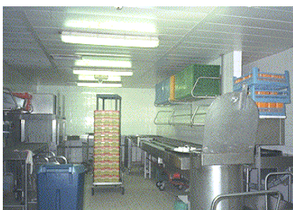
Entrée du broyeur en bas à droite dans la photo [doc. COSTIC]
